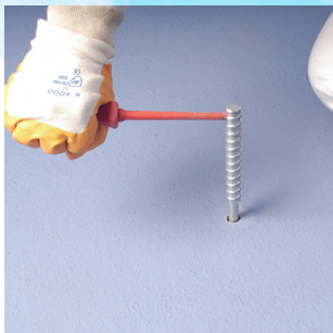
Bohrkernverankerung spannen
